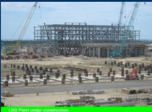
LNG Plant under construction
